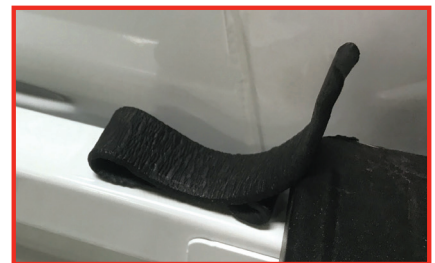
Plier le morceau en trois, à environ 5 cm du protège-rebord.
