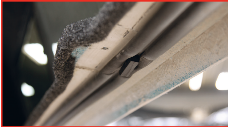
Position d'une entretoise (en gros plan), qui doit être enlevée.
