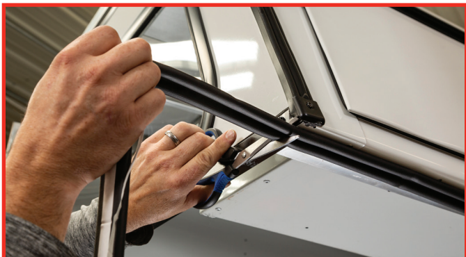
Fig. A À partir de l'arrière, côté conducteur, appliquer le joint double de bulbe de 5/8" sous le bord extérieur de la boîte, en ligne droite vers l'avant.
